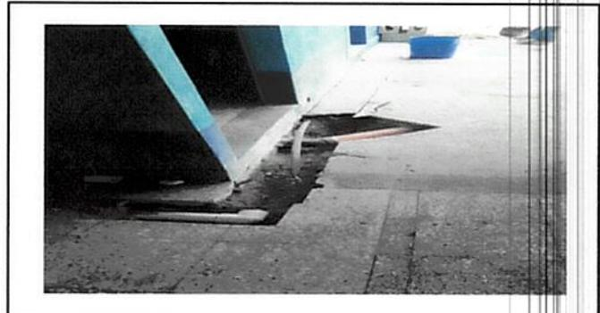
pertenece a modulos 2: perforando para instalar tubería PVC
